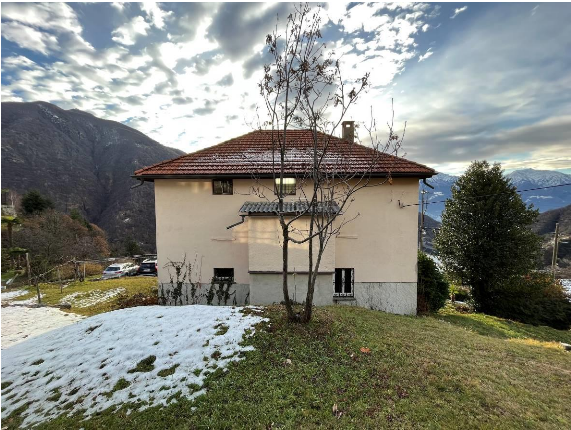
Foto 14: abitazione vista da monte
