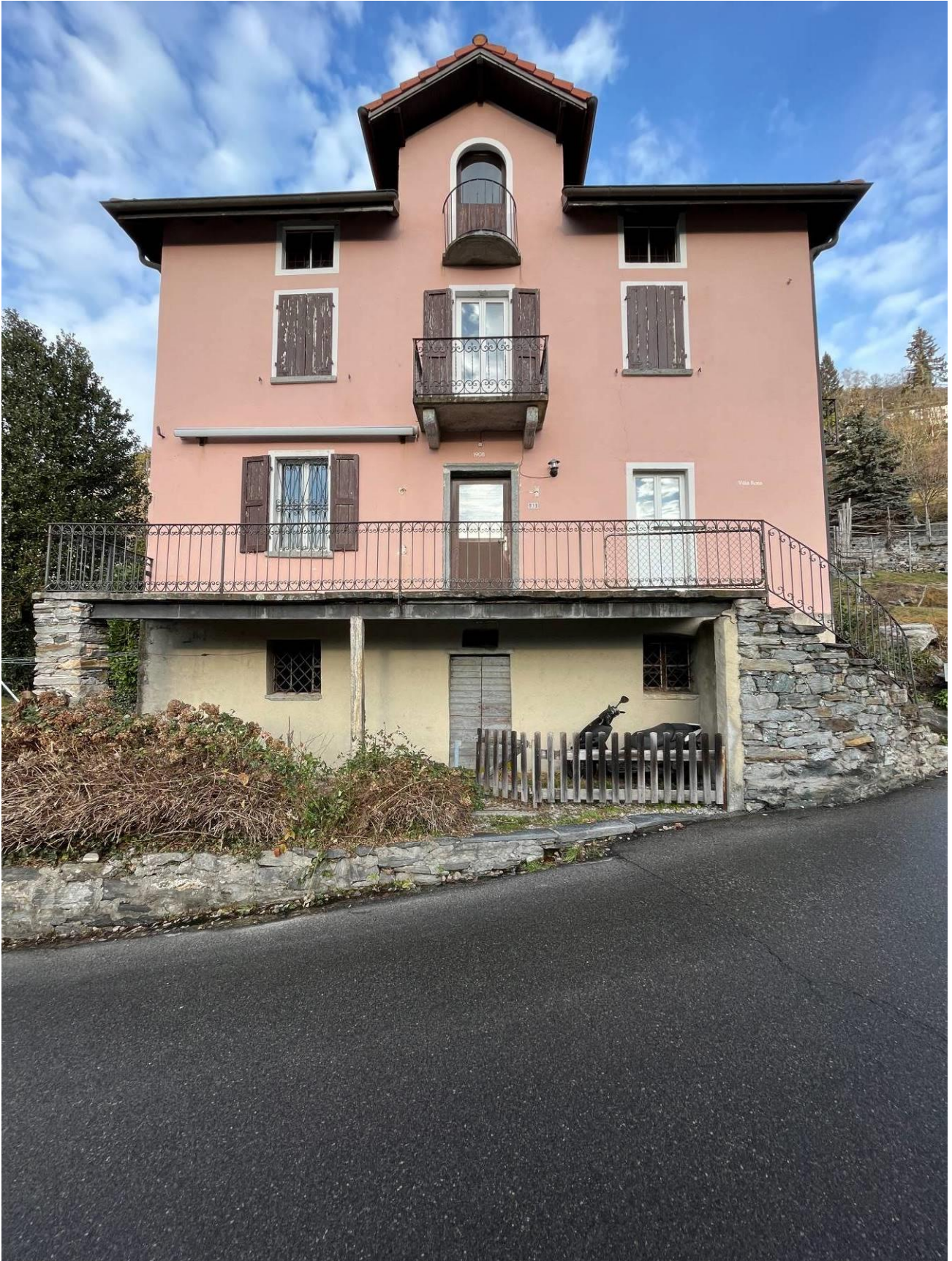
Foto 15: abitazione vista da valle
