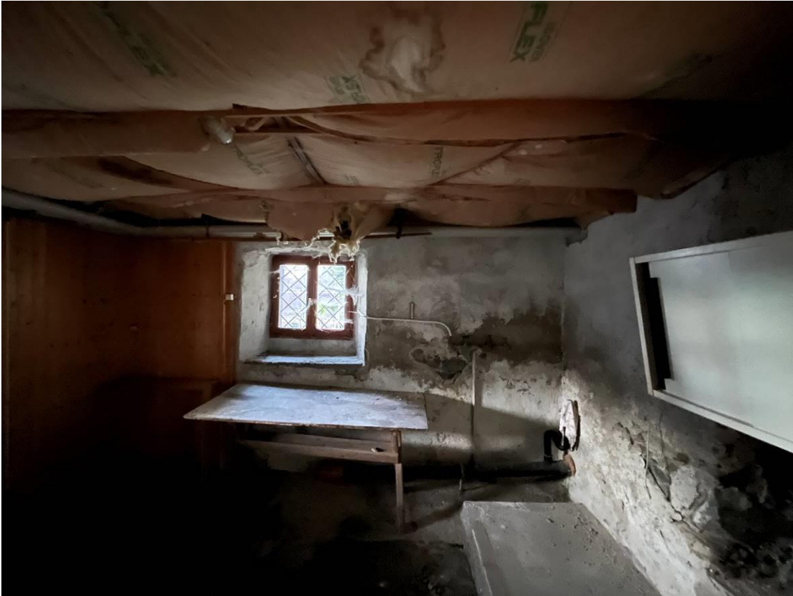
Foto 13: deposito al piano cantina
